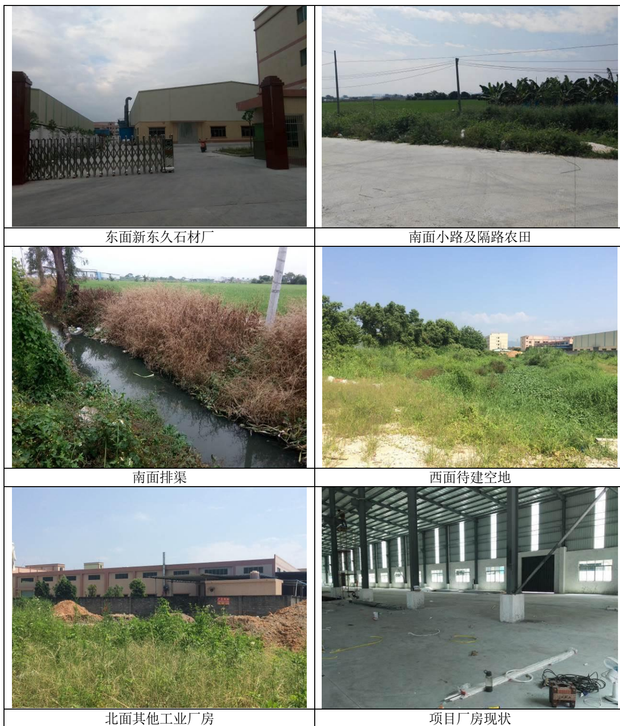
2.2-5 项目实景照片
