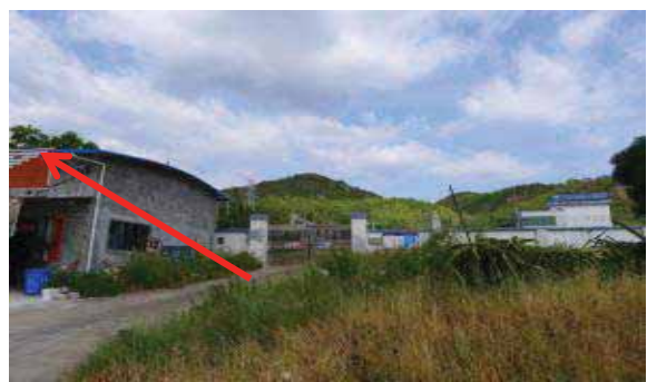
110kV 平海站接线方向
