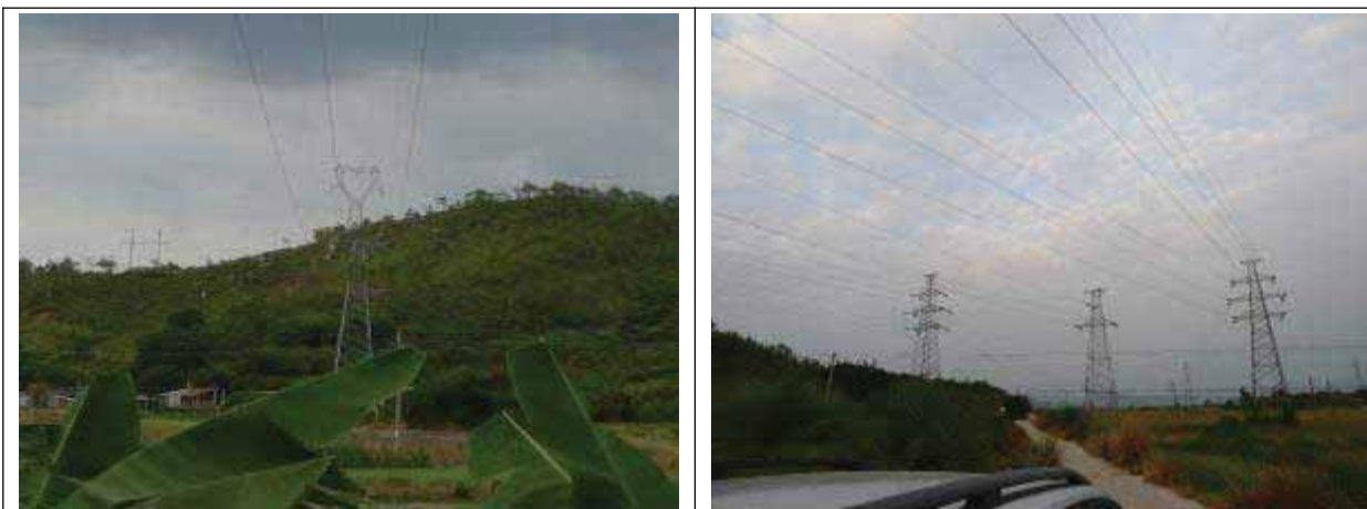
图 1-4 110kV 铁海甲、乙线现状
