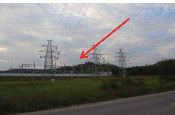
220kV 铁涌站接线方向
