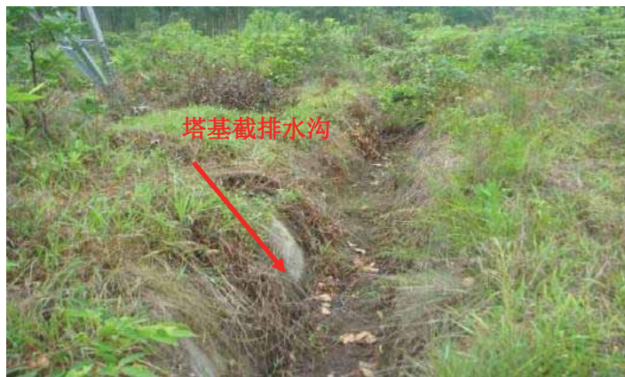
图 12-1 同类工程塔基截排水沟
