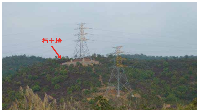
图 12-2 同类工程塔基挡土墙
