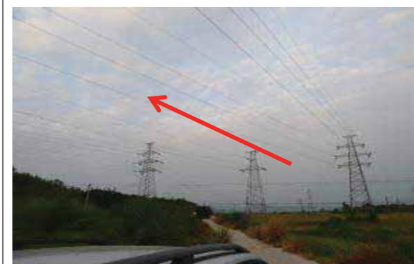
110kV 铁海甲乙线改造工程线路方向
