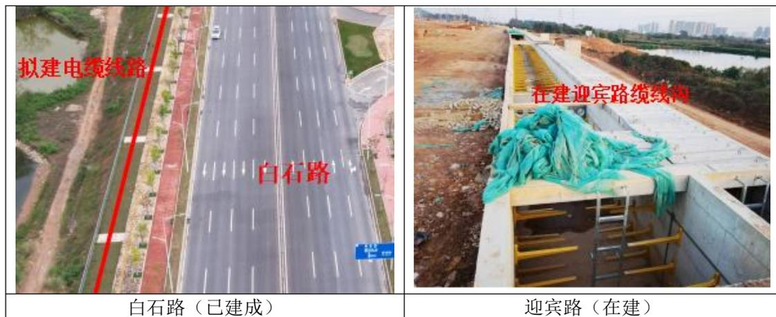
图 2-4 本项目电缆线路依托市政道路综合电缆沟建设情况现场照片
